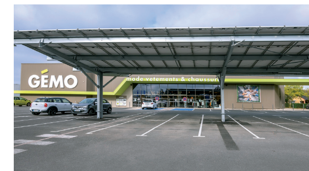
Solar canopy, Géo Trignac.
